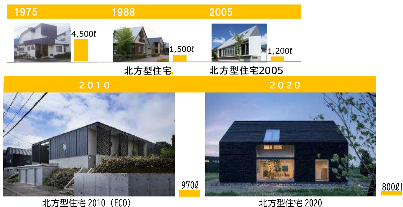
図Ⅱ-2-6 北海道の住宅の変遷（年間の暖房用灯油使用量の推計） （出典：北海道建設部住宅局資料）
